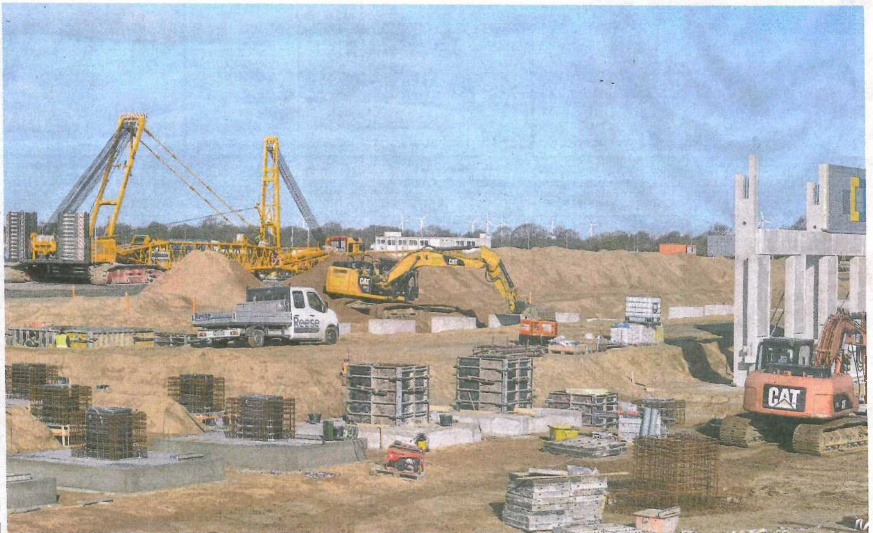
Links auf dem Foto wird der große Raupenkran montiert, rechts ist ein Teil der Musterfassade in den Edeka-Farben gelb und blau zu sehen.
