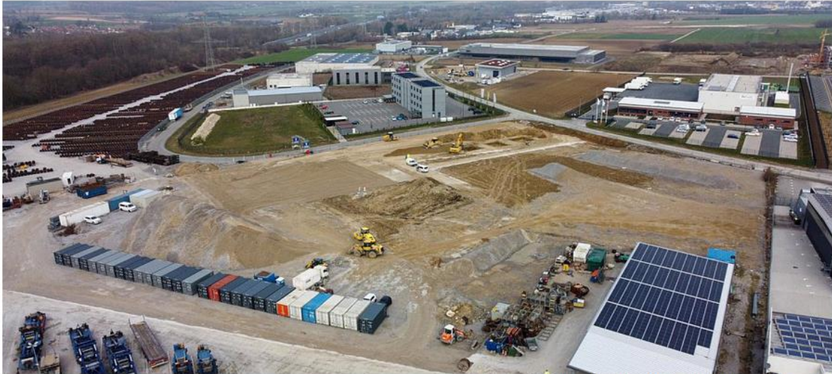
Auf diesem Gelände entsteht die 8.000 Quadratmeter große Lager- und Logistikhalle der Universal Transport Gruppe. | © Universal Transport
