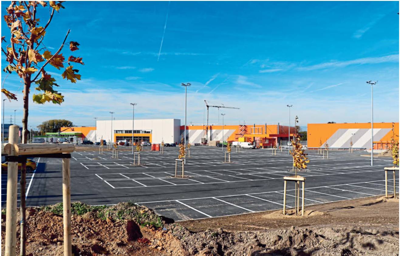
Auf dem Parkplatz des neuen Hornbach-Baumarkts wurden bereits Bäume gepflanzt. Aktuell werden die Schilder im Außenbereich aufgehängt und im Markt selbst letzte Maler- und Elektroarbeiten durchgeführt. Foto: Mareike Grönweg
