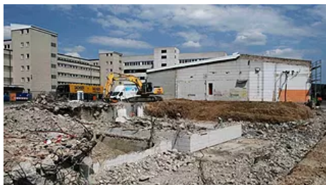
📷 Um Platz für den Neubau zu schaffen, werden die Gebäude auf der Rückseite der Baur-Logistik abgebrochen. Foto: Gerhard Herrmann
