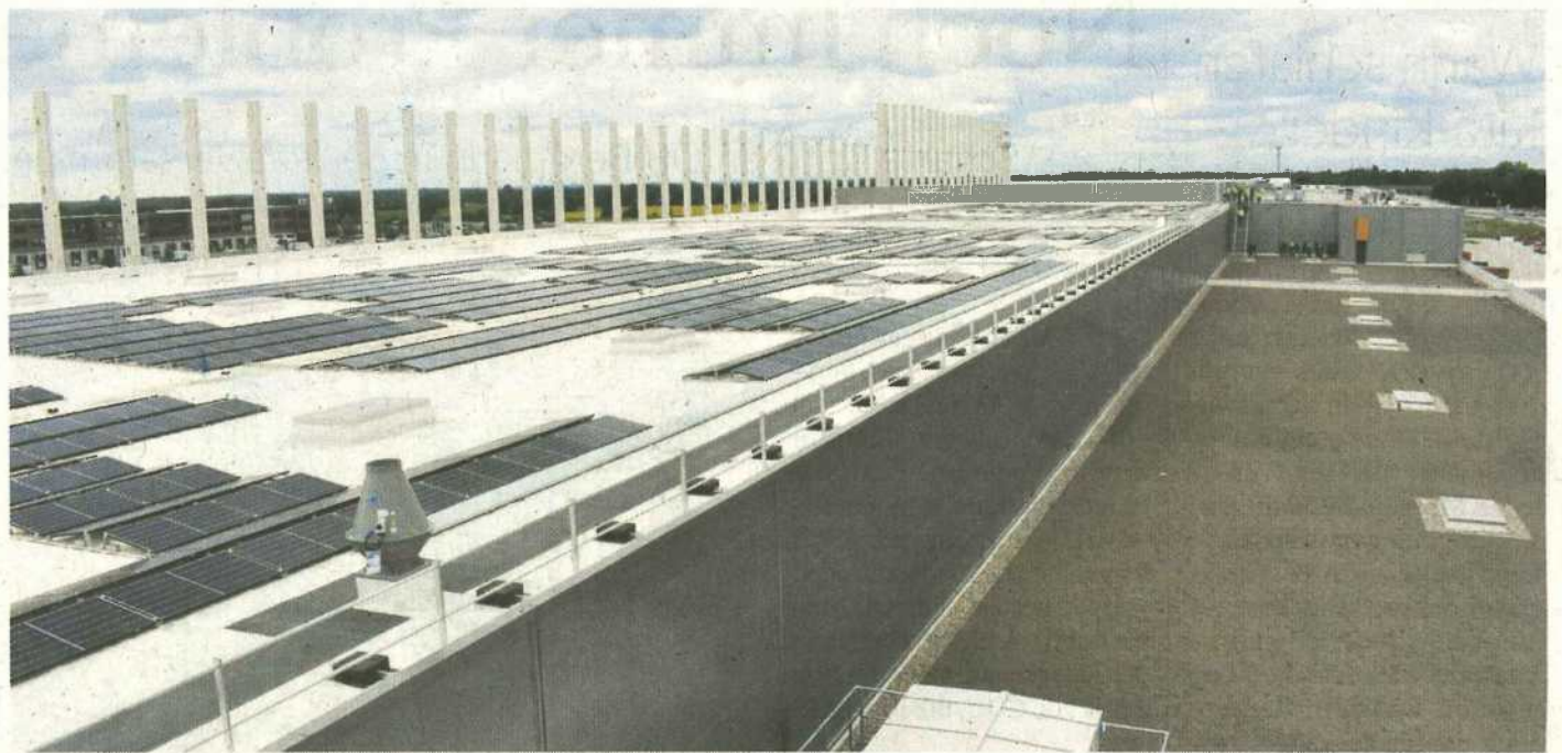
Ein Blick auf die Dachfläche des neuen Edeka-Zentrallagers: Die rechte Seite soll begrünt werden, links sind Photovoltaik-Module platziert. Fotos: Christian Lipovsek
